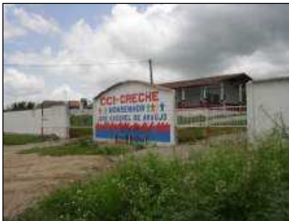
Foto 3.47 – Creche está Localizada às Margens da PE-112
