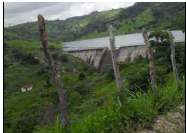
Foto 3.73 – Vista da Localização da Casa de Bombas
