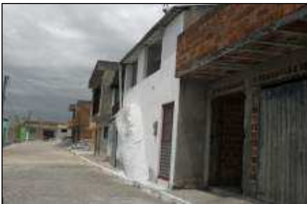
Foto 3.70 – Edificações Avançado no Passeio Público sem Controle Urbano
