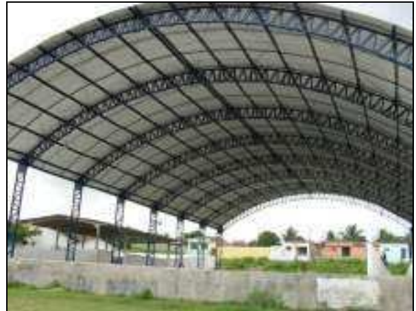
Foto 3.54 – Quadra Poliesportiva no Bairro Novo Tempo
