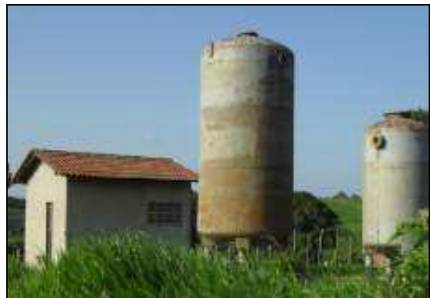
Foto 3.78 – Casa de Bombas e ETA Compacta Ambas em Construção – Distrito de Vila de Santana
