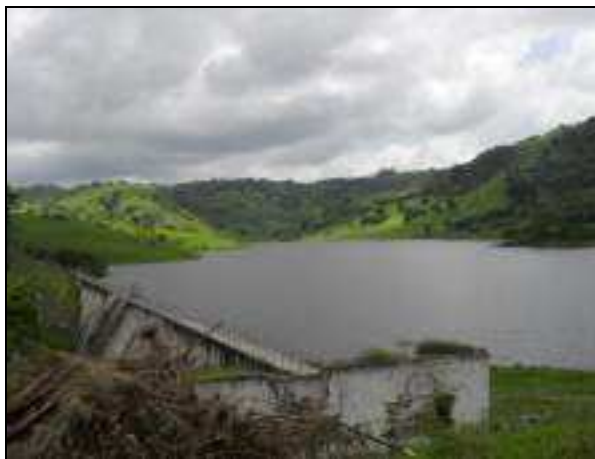
Foto 3.72 – Vista da Tomada d'Água da Barragem Caianinha
