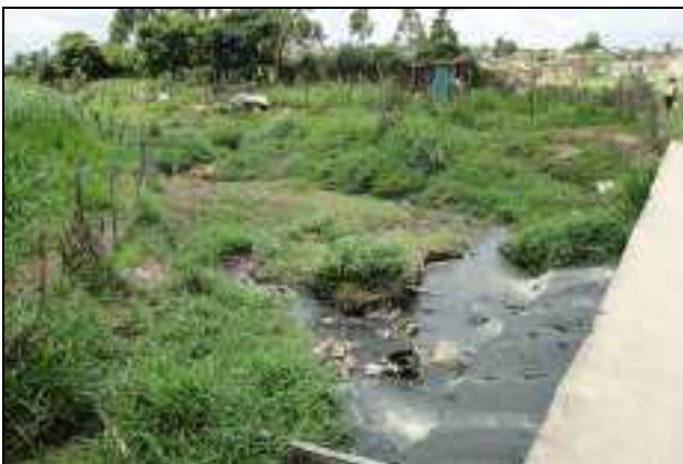
Foto 3.5 – Lançamento de Esgotos e Resíduos Sólidos no Riacho Caianinha pela População do Município de São Joaquim do Monte
