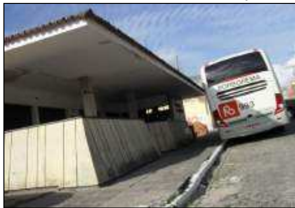
Foto 3.88 – Terminal Rodoviário de São Joaquim do Monte
