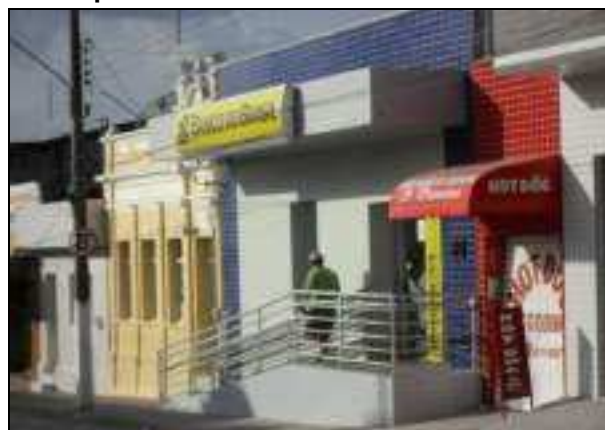
Foto 3.89 – Rampa de Acessibilidade Instalado no Banco do Brasil
