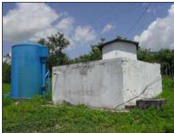
Foto 3.79 – Sistema de Abastecimento da Localidade Monte Alegre
