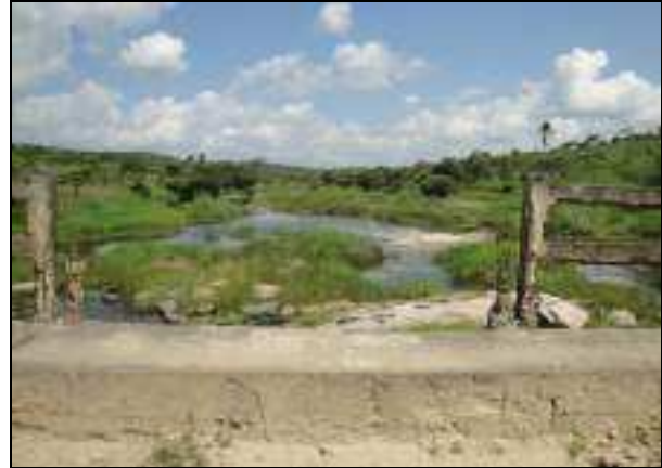
Foto 3.12 – Aspecto do Desmatamento da Mata Ciliar do Rio Una para uso da Agricultura na Porção Rural, Distrito de Barra do Riachão, Município de São Joaquim do Monte
