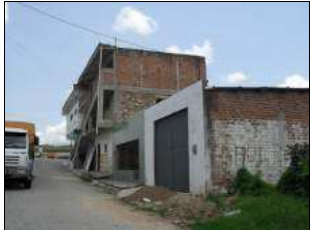
Foto 3.23 – Edificações de 3 Pavimentos na Sede Urbana
