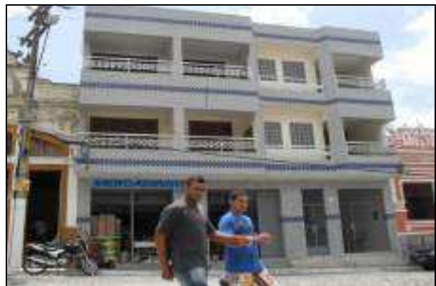
Foto 3.69 – Construção de 3 Pavimentos com Avanço no Espaço Aéreo
